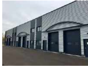
- MARGNY LES COMPIEGNE - Location 1 526 m 2
